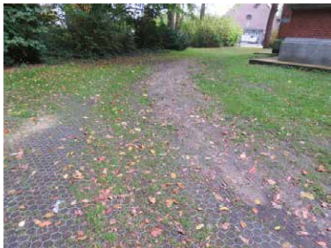
figuur 131: kassei en verhard gazon met nidaplast (foto 28/09/2017)
