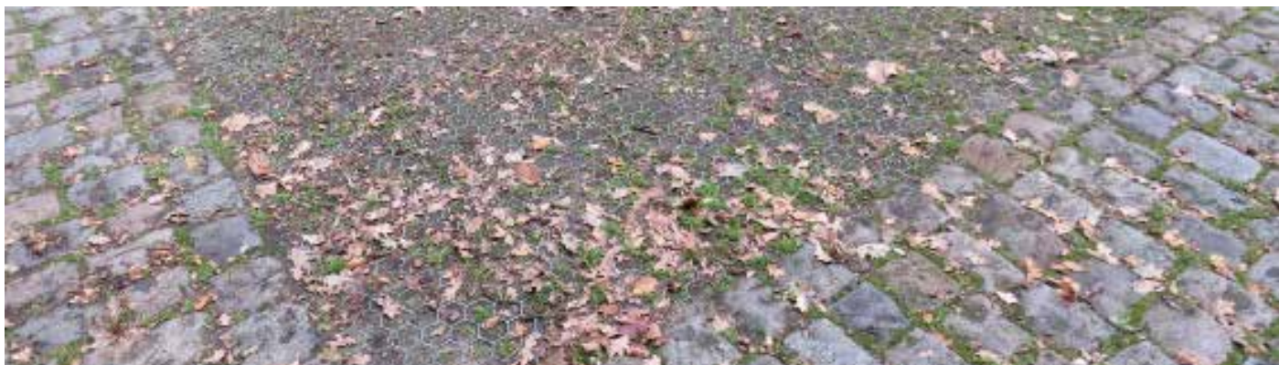
figuur 129: kassei en verhard gazon met nidaplast (foto 28/09/2017)
