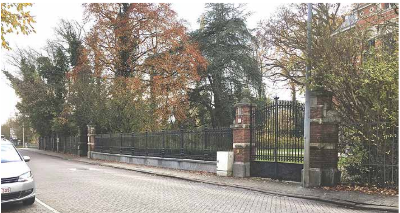
figuur 148: diverse foto's smeedijzeren hekwerk en poorten
