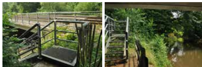
figuur 156: onderdoorgang spoorwegbrug (foto 28/09/2017)
